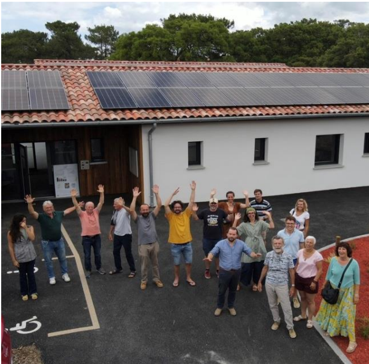
Exemple de réalisation d'ALOé à Seignosse, sur le centre de loisirs L'île aux couleurs (36 kWc, 2023)
